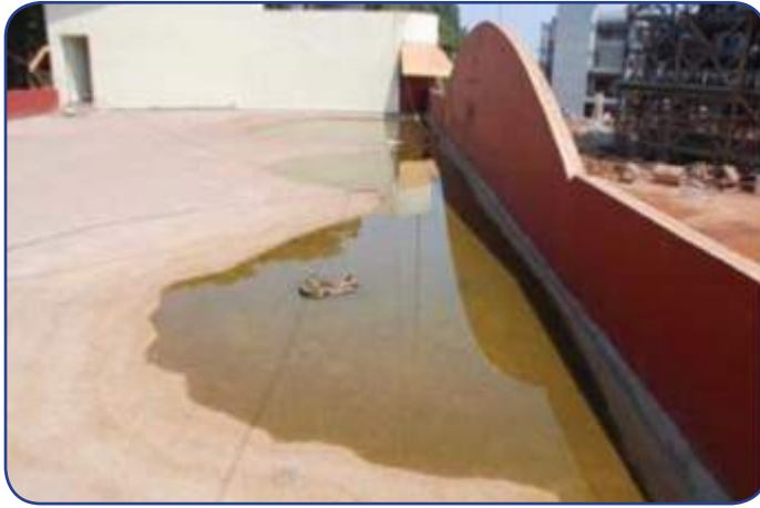
شکل ۴۷: بالکن و تراس مسدود شده با آب جمع شده
