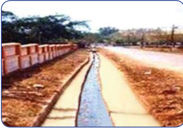
شکل ۳۹: حاشیه‌های منظم و صاف یک کانال آب، موجب جریان راحت آب می‌شود.
