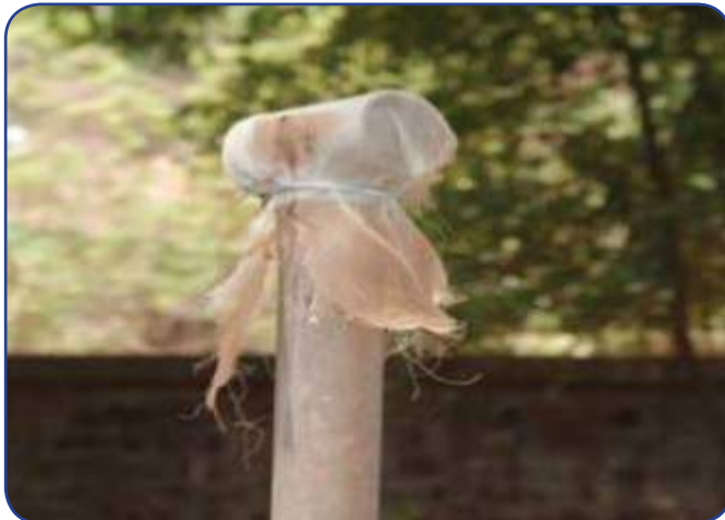
شکل ۴۲: منفذ انتهایی لوله برای جلوگیری از ورود پشه‌ها با توری نایلونی پوشیده شده است.
