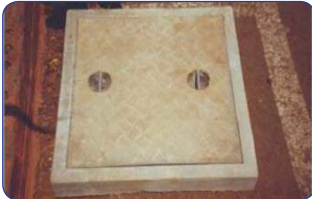
شکل ۴۰: این درپوش مانع پشه، وقتی به اندازه باشد باعث بسته شدن کامل من هول می‌گردد.
