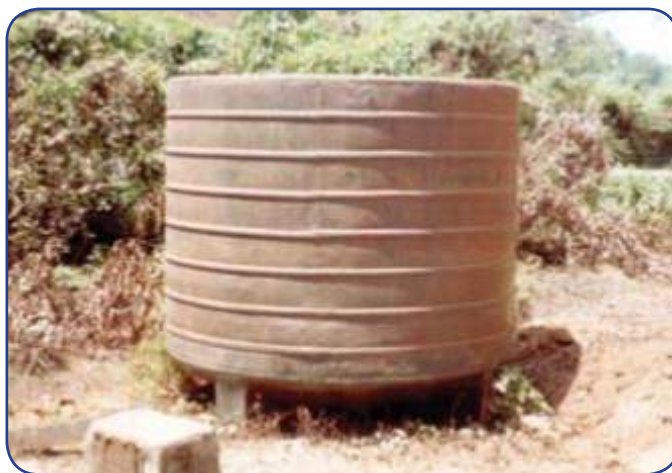
شکل ۳۷: تانک عمودی بدون استفاده باید وارونه نگه داشته شود.
