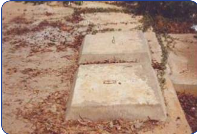
شکل ۴۱: مخازن فاضلاب کاملاً بسته شده برای جلوگیری از تخمگذاری کولیسینه‌ها به خصوص کولکس کواپنکوفاسیاتوس
